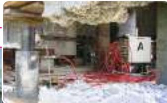
Sollevamento sincrono con Synchrolift per la ricostruzione delle fondamenta di una casa (Germania 2003)
