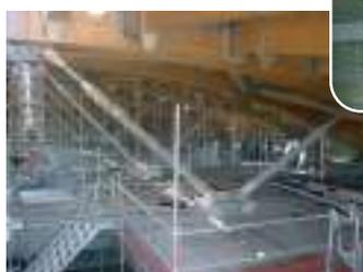
Sistema di tensionamento della struttura di supporto della copertura del nuovo Auditorium della Musica di Roma. In questo caso sono stati usati cilindri tensionatori speciali prodotti da EUROPRESS. (Roma, Italia, 2001)
