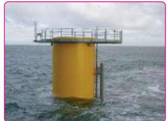
Fondamenta di uno dei 30 generatori eolici da 30 MW installati nel Mare del Nord e livellati con 6 CGS50N100 che hanno lavorato a 10-15 metri sott'acqua.
