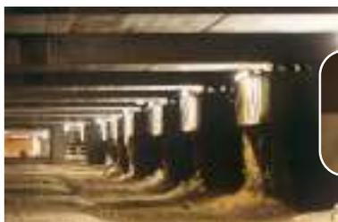
Sollevamento della stazione ferroviaria di Anversa per la costruzione della linea metropolitana sottostante. (Anversa, Belgio, 2000)
